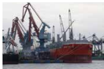
▲북부자카르타 만중 브리옥 자카르타 국제컨테이너터미널(JICT) (사진=자카르타경제신문/Aditya)
